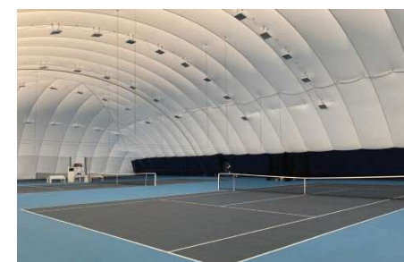
Courts de Tennis résine sous dôme
